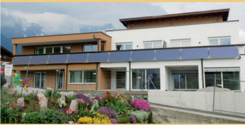
Nicht am Dach, sondern vorgelagert am Balkon, sammeln die Solarpaneele die Sonnenstrahlen ein und versorgen die BewohnerInnen mit Warmwasser
