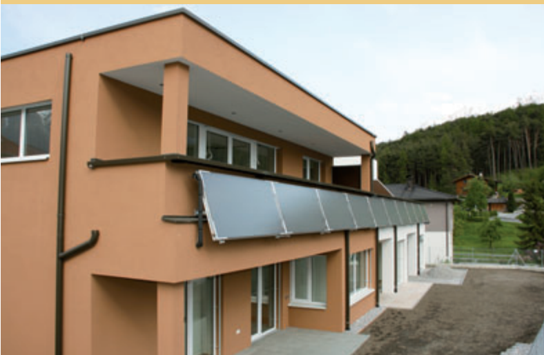
Nicht am Dach, sondern vorgelagert am Balkon, sammeln die Solarpaneele die Sonnenstrahlen ein und versorgen die BewohnerInnen mit Warmwasser
